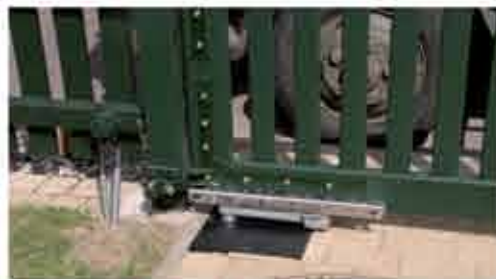
Holztor mit BFT EII 250 BT Unterflurantrieb
