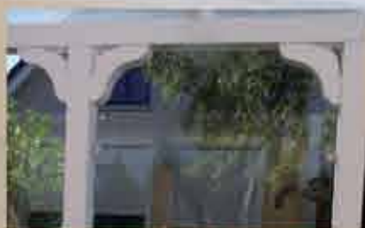
Terrassendach in weiß mit aufwendig verzierten Kopfbändern, Seitenwänden aus Holz und Sicherheitsglas; Terrassenboden aus Bangkirai
